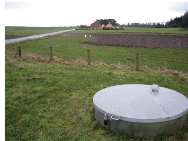
Kilde: Skødshoved Vandværk. Vandboring i tørbrønd.
