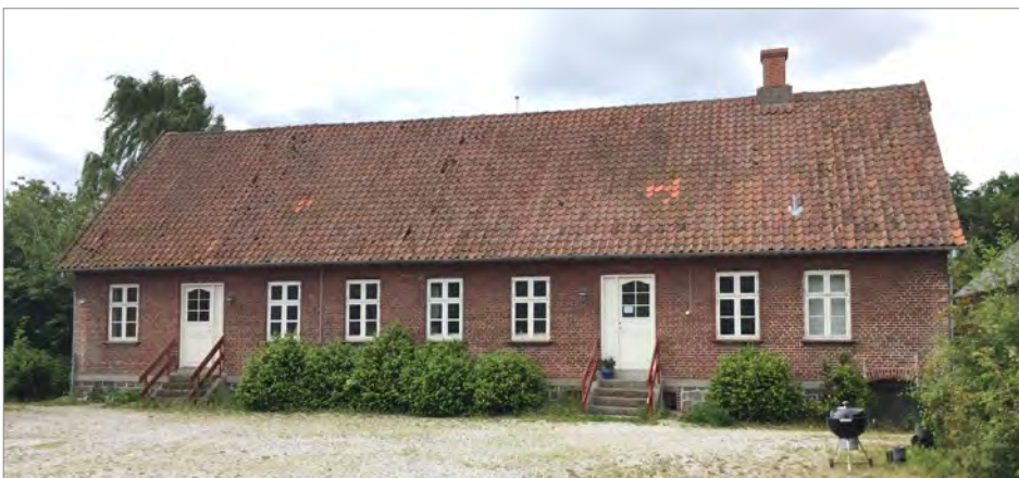
Bevaringsværdige bygninger ved eksisterende landejendom Randersvej 22
